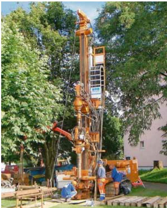
Ein ähnliches Bohrgerät soll im Wald zum Einsatz kommen.
